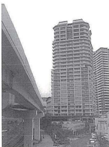
JR東海道線(左下)、六甲ライナー(高架)が近接して走る現場
