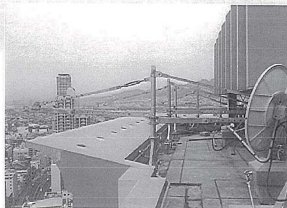
作業用ゴンドラを吊るすために設置されたブーム
