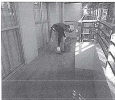
バルコニー内のウレタン塗膜防水作業の様子
