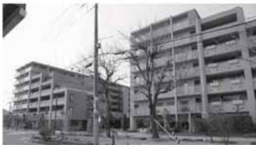
管理組合の異なる2棟が一緒に大規模修繕を行い無事、完了した
